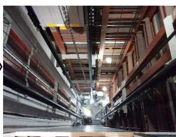
ステップ2 組立工事
