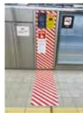
多摩モノレールではホームからの転落防止や電車との接触を避けるため、全駅にホーム柵を設置しております。しかしながら、お客様が「ホームの下へ転落してしまった!」「柵（レール）の上に人が乗っている!」等の危険な状況がありましたら、ホーム柵に設置している「非常停止押しボタン」を押して下さい。
